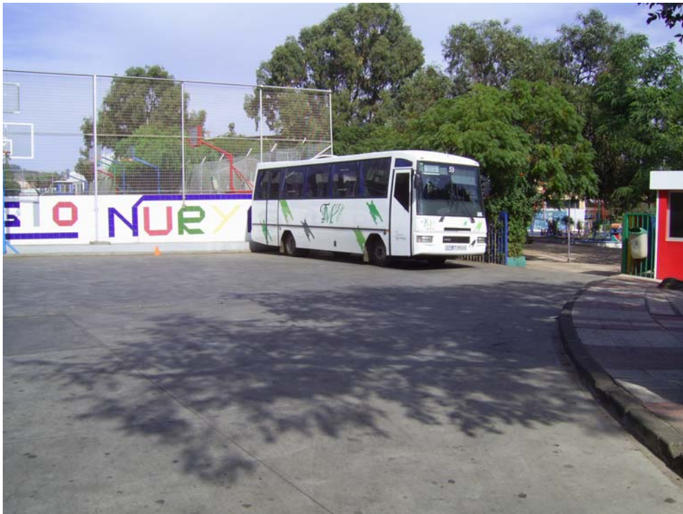
Imagen 8.- Vista del aparcamiento de guaguas del Nuryana. Se puede observar la superficie que ocupa, bajo la cuál se encuentra el aljibe con capacidad superior al millón de litros.
