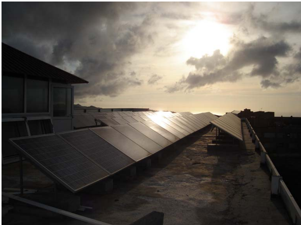
Imagen 2.- Vista del tejado del Nuryana con los paneles iluminados por el sol del amanecer
